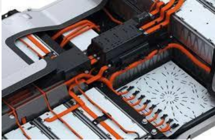
Şekil 4.16 : Modüller arası busbar bağlantıları.
